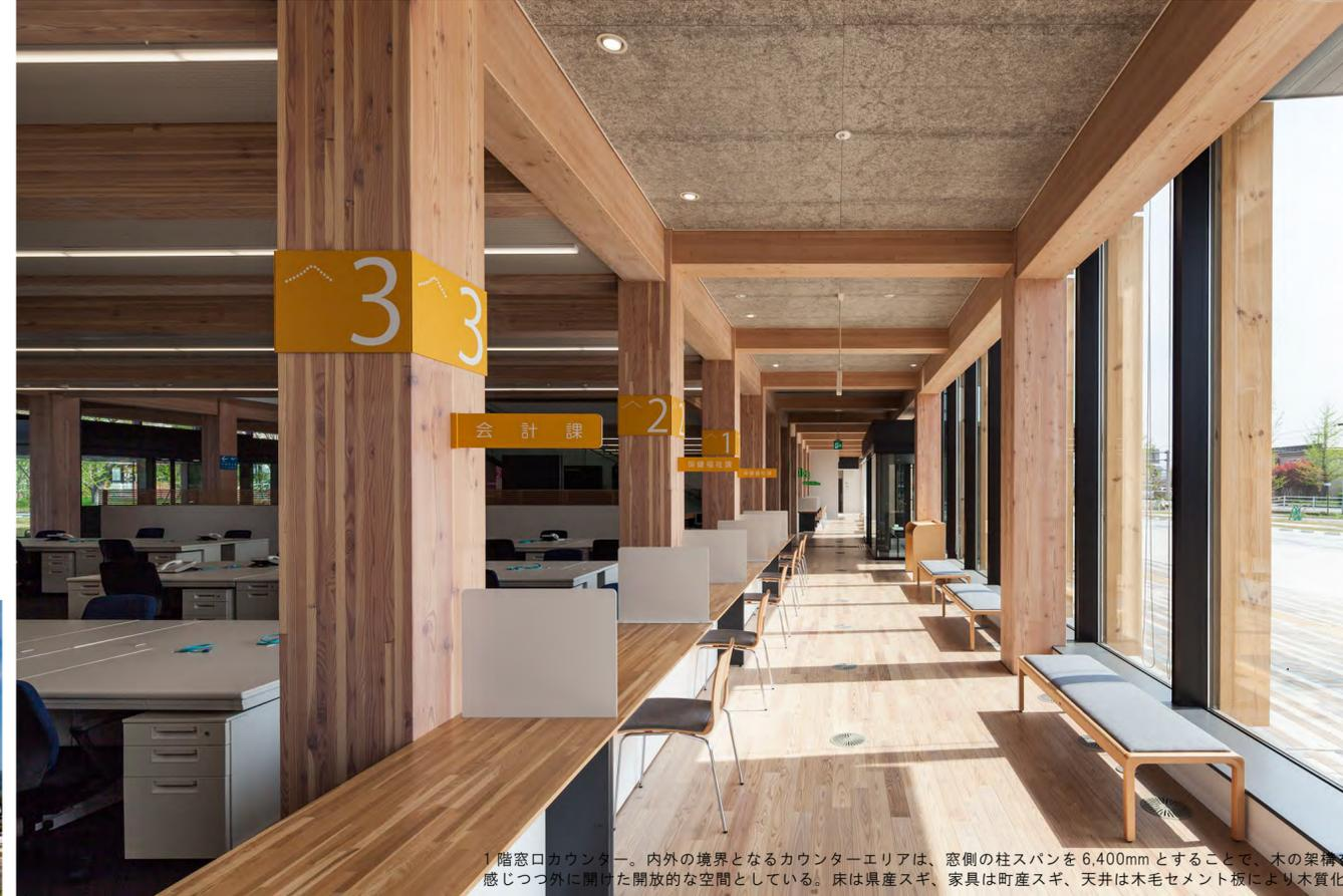
1階窓口カウンター。内外の境界となるカウンターエリアは、窓側の柱スパンを6,400mmとすることで、木の架構を感じつつ外に開けた開放的な空間としている。床は県産スギ、家具は町産スギ、天井は木毛セメント板により木質化。
