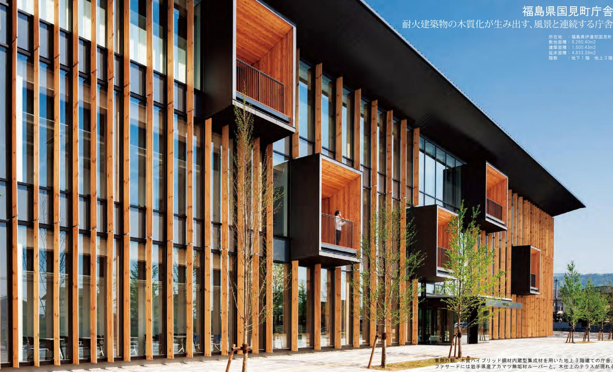
東側外観。木質ハイブリッド鋼材内蔵型集成材を用いた地上3階建ての庁舎。ファサードには岩手県産アカマツ無垢ルーバーと、木柱上のテラスが現れる。
