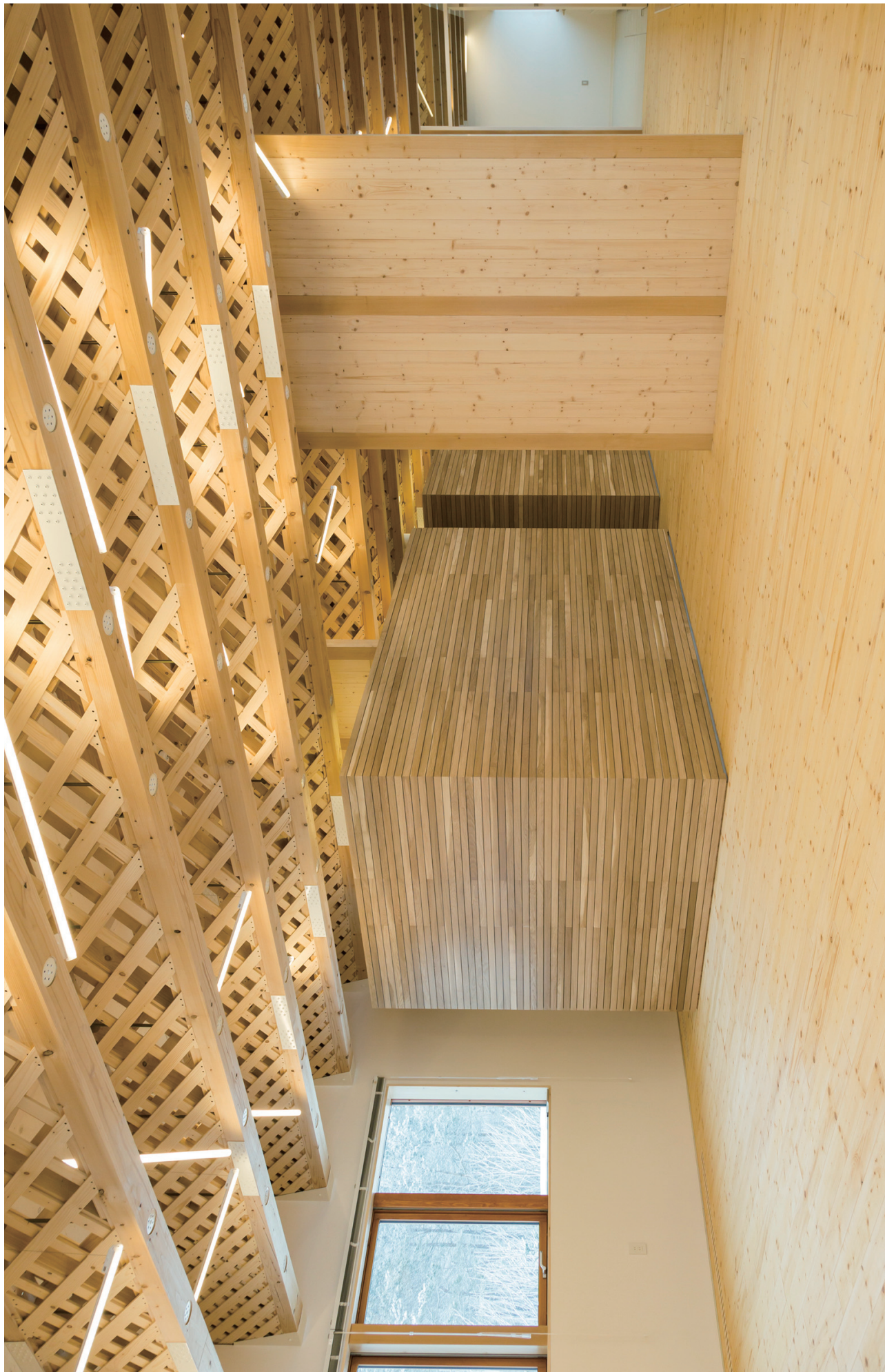
オフィス内観。ミーティングスペースと執務スペースをトドマツの耐力壁が緩やかに区切る。トイレやキッチンを囲むボックスはミズナラ、50mm ピッチの深い溝に小さな棚を差し込みサンプリルなどを展示できる。
