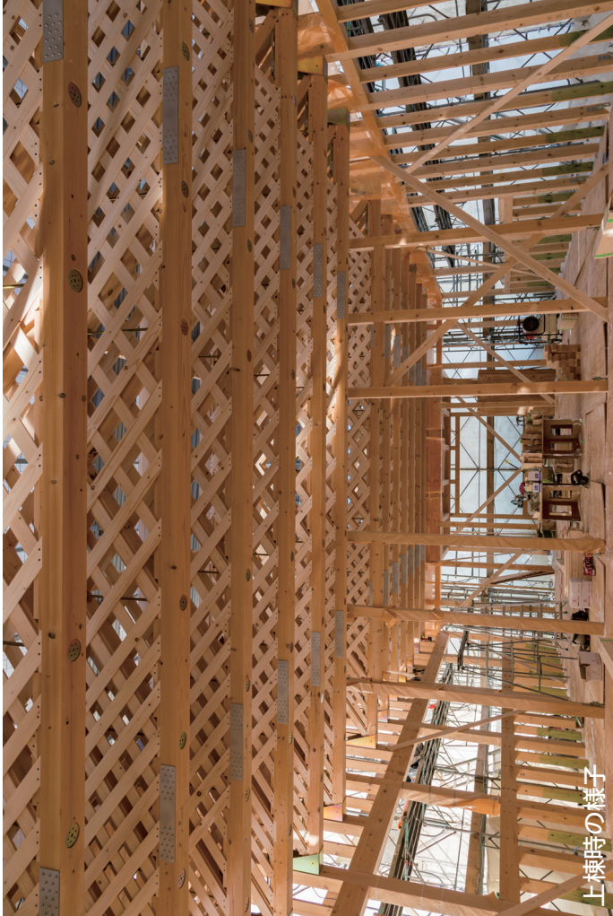
トラス・ラティス梁見上げ。天井面は24mmのトドマツ合板をあらわしとしている。
