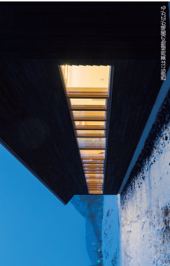
西側外観。カラマツ燻煙材は燻煙するバイオビレッジ建物群にも使用され、地域の景観を作り出している
