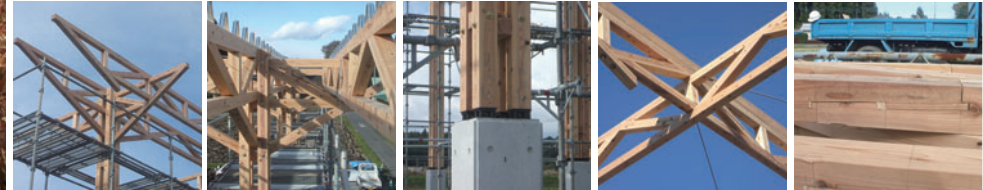
①A通りトラス先端部 ②B通りトラス交差部 ③柱脚部 ④C通りトラス交差部 ⑤金輪継ぎ手
