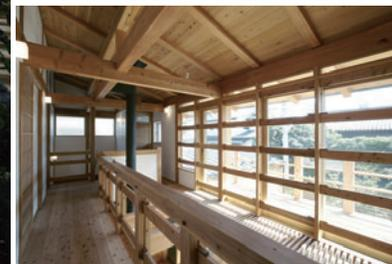
2階吹抜け、ガラス面には貫を設置し、日除けと防犯を兼ねて計画している。
