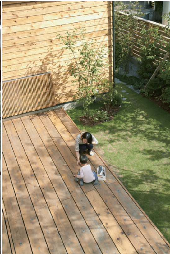
室内の延長として使用出来るデッキ。デッキ材の幅は室内フローリング幅と合わせている。
