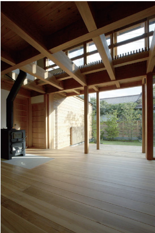
下の間より前庭を眺める。梁材は方向性を出すため3尺ピッチで渡している。開口部の木製サッシは引込み可能。
