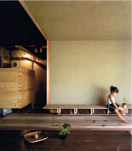
2 調湿機能を期待した再生土で仕上げられた壁・天井。貫壁とその補強部材を下地。左に見える高野積積層壁の向こうはトイレ。
