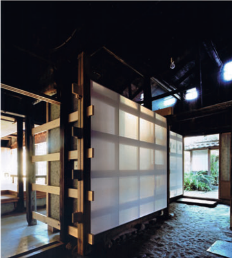
6 キッチン収納。右奥に見える洋埦場を想起させる白く光る和紙の壁により内外・新旧を連続させている。和紙の向こうに耐震補強用の貫壁が透けてみえる。
