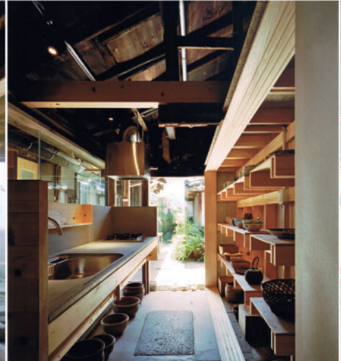
5 キッチン土間。正面奥通り庭にある洋埦場と右の収納部との壁面線をあわせ、廊からキッチン土間の連続性を強化。キッチン収納は貫壁の補強部材を利用して作られている。
