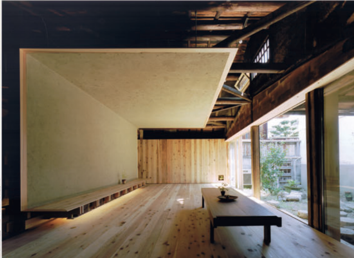
3 キッチン土間から奥間をみる。左手に見える再生土を利用した壁・天井の連続面が坪庭から差し込む光を柔らかに包み込む。中央奥に見えるスチール壁は既存部との間に収納が隠されている。天井部に見える斜材は古材でありこれにより水平剛性を確保。
